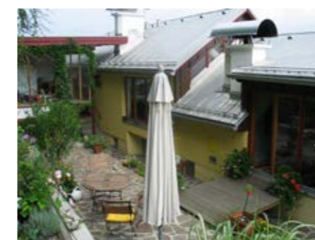
Die ehemals finstere und feuchte Wohnung wurde modernisiert und trockengelegt
