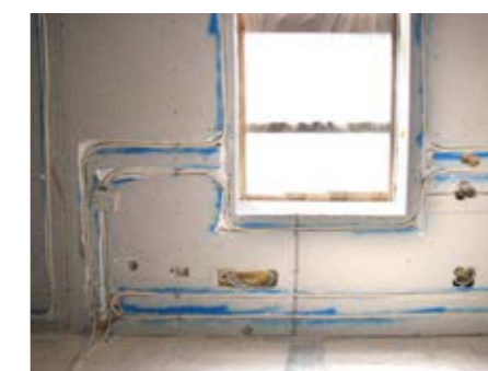
Die Leitungen wurden im Sockelbereich und in Parapet-Höhe verlegt
