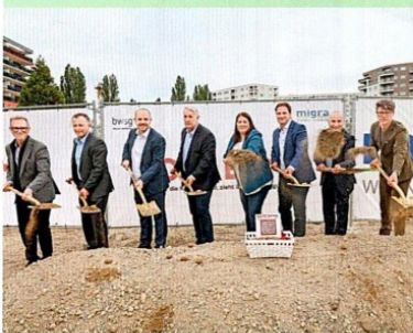
Spatenstich im 22. Bezirk in Wien – das Projekt „Rote Emma“ der BWS und Migra
