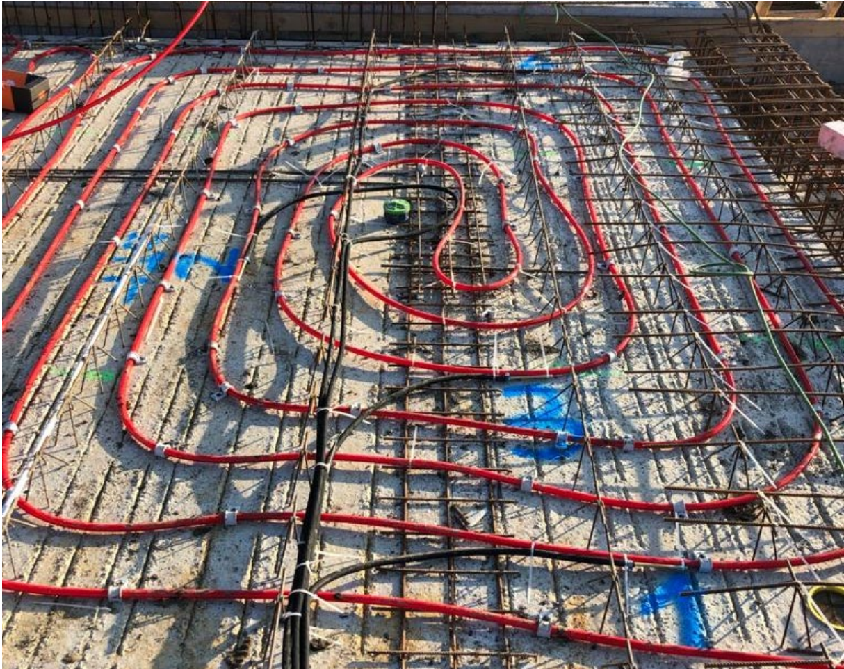
Abb. 62: Schneckenförmig verlegtes Register des Heizkreises 6 in der Decke der Wohnküche von Reihenhaus RH_S
