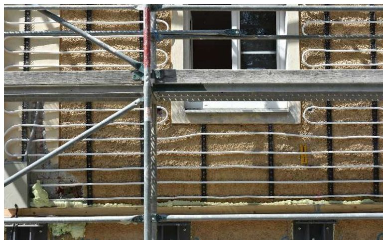
Abb. 12 Projekt „Wohnen findet statt“ Befestigung der Rohrleitungen am Bestandsmauerwerk @ FH Salzburg
