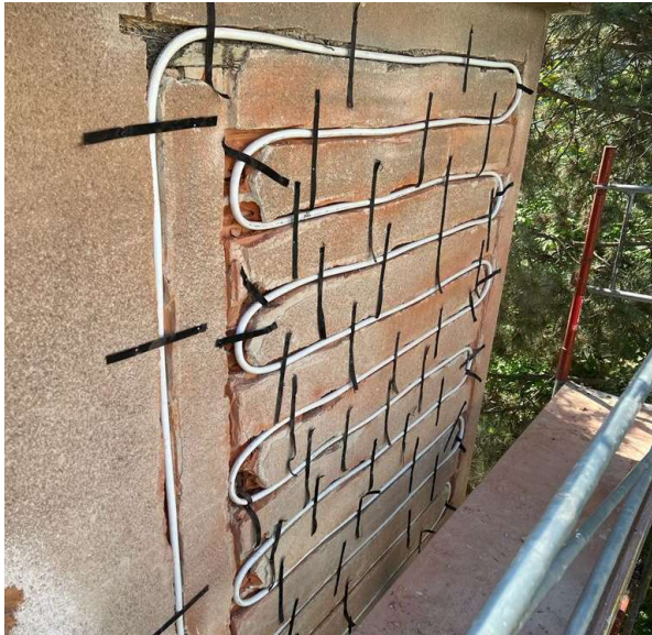
Abb. 17 Projekt „Sani60ies“: Einfräsen der Rohrleitungen in den Mantelbetonsteinen © Institute of Building Research & Innovation ZT GmbH
