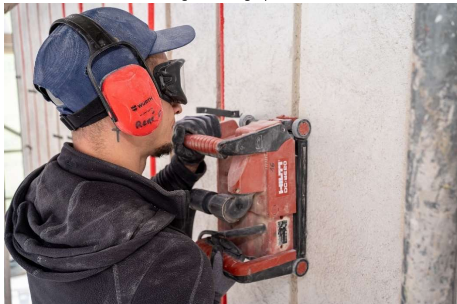
Abb. 16 Sanierung Wohnbau „Sani60ies“ @Sozialbau AG
